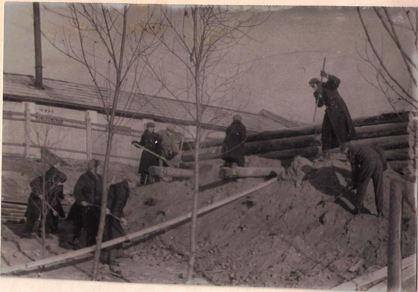
На строительстве тира
