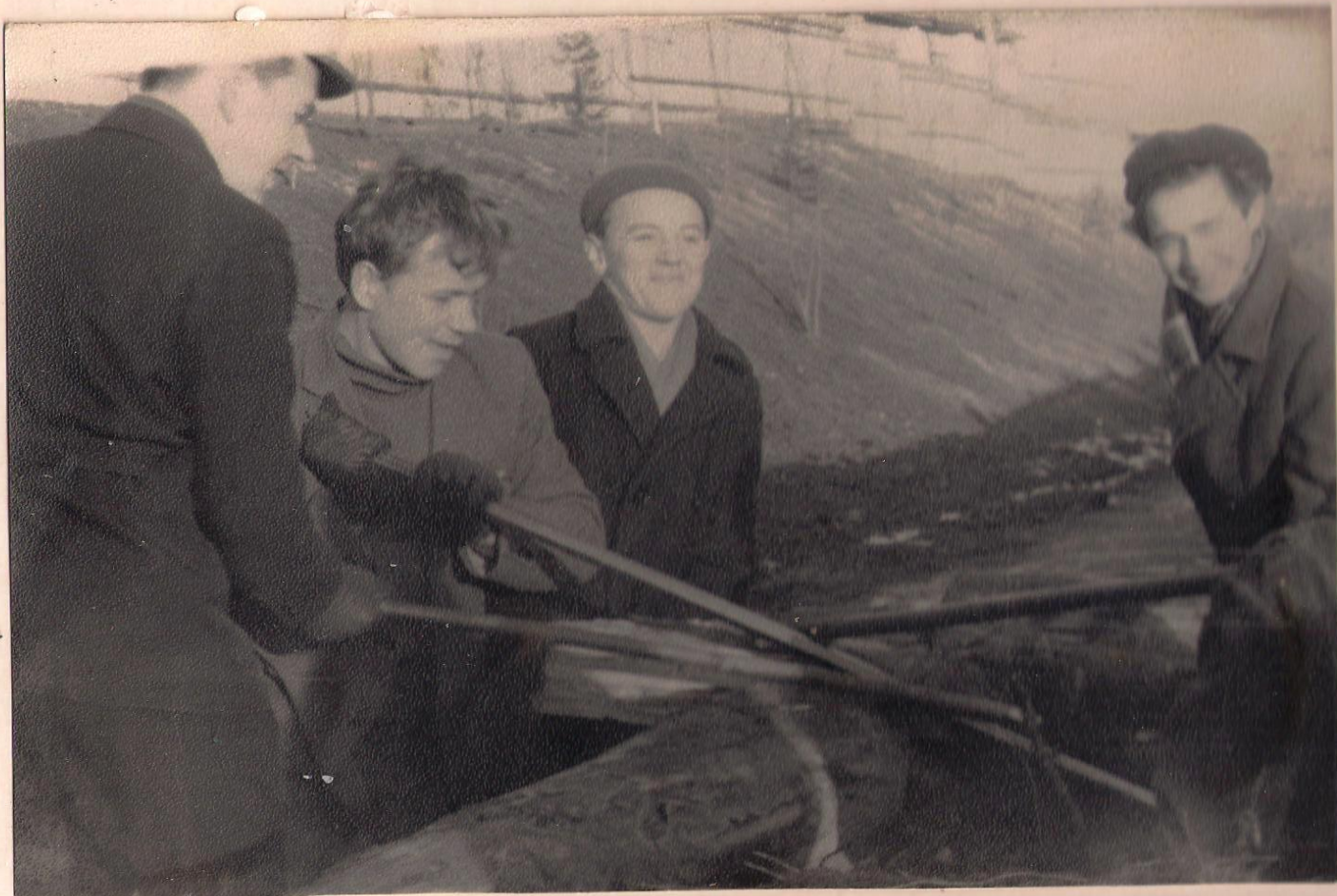
На строительстве тира
